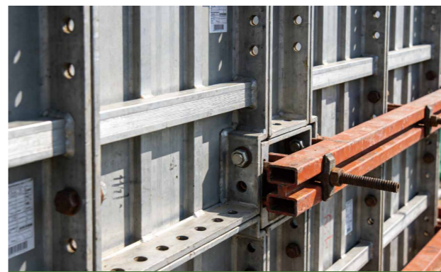
使用强度高、重量轻的铝膜，可实现全部回收再利用
