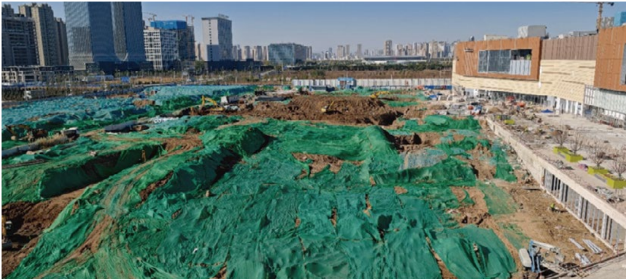
▲ 项目实景图-邯郸万象汇施工现场
