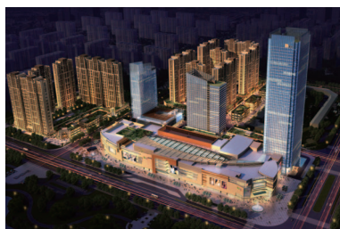
贛州華潤中心 Ganzhou City Crossing
