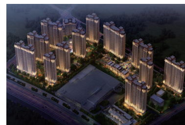
南京悅府 Nanjing Ning Mansion
