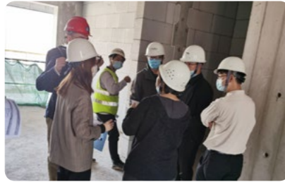
▲ 武汉公司开展项目现场检查
