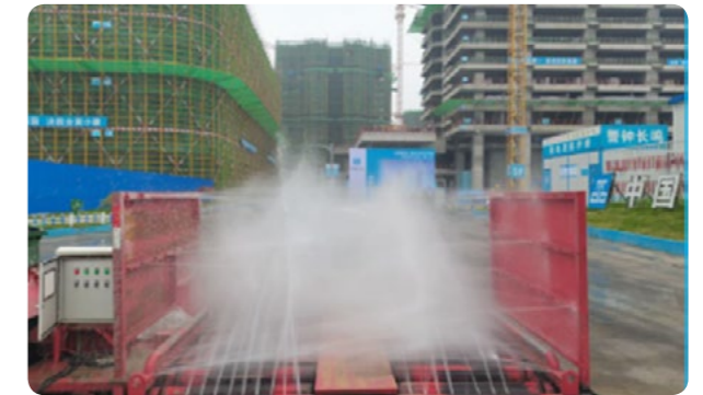
▲ 施工现场设置冲洗设施
