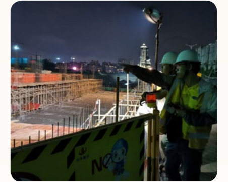
▲ 24小时值班值守项目工地
