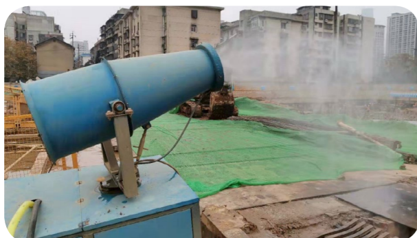
▲ 项目现场扬尘喷雾
