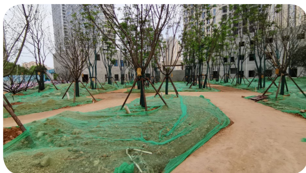
▲ 项目现场裸土覆盖
