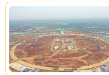
基础土方开挖 / 06-27
