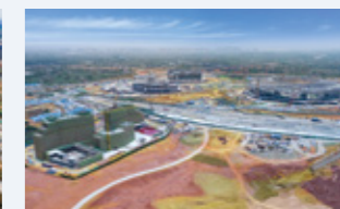
成都东安湖体育公园已提前完成主体结构、钢结构施工
