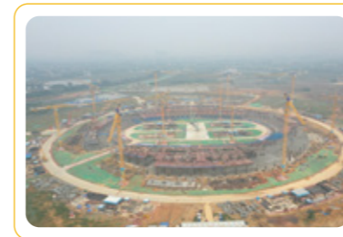
主体结构封顶 / 11-30
