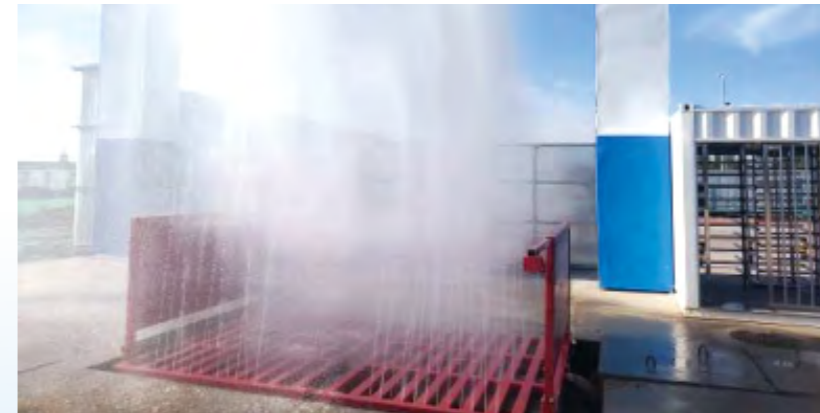
石家庄项目洗车池废水 2 级沉淀，重复使用
