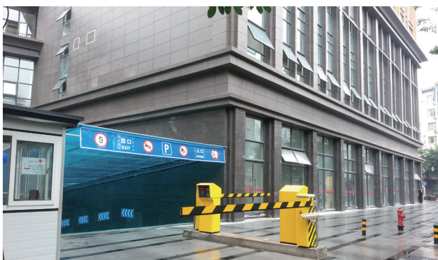
案例3：成都通锦桥项目
